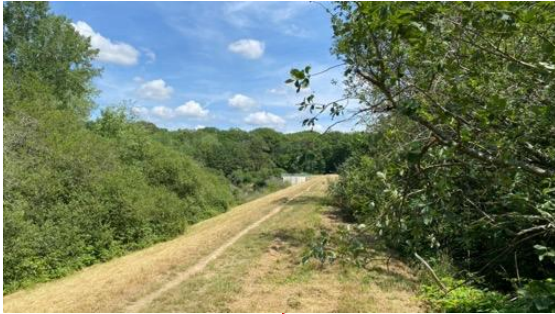
Magny 4 : Chemin de digue / etang
